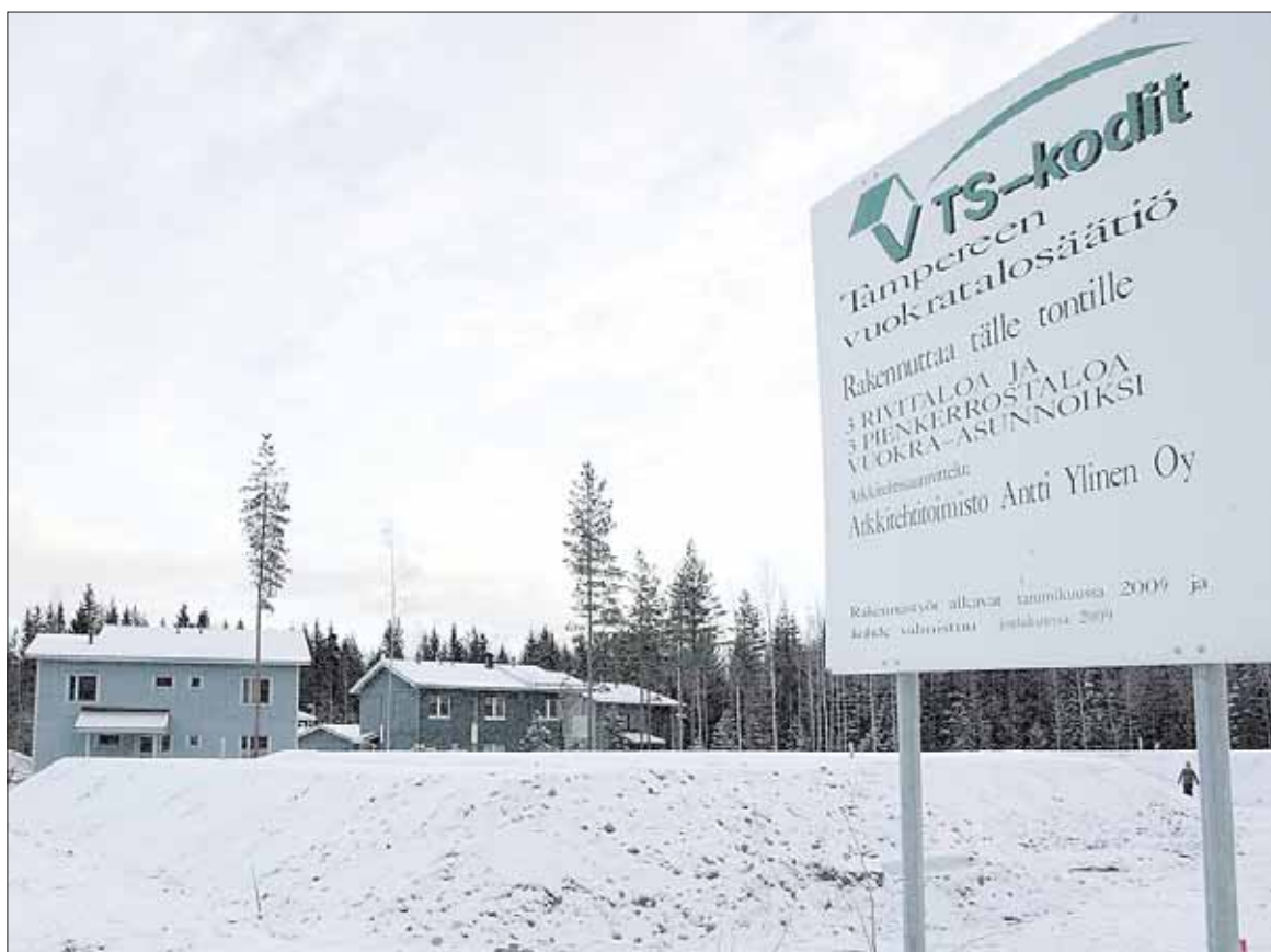
Kalkun Linnoituksenkadulla on aloitettu uusien rivi- ja luhtitalojen rakentaminen.
