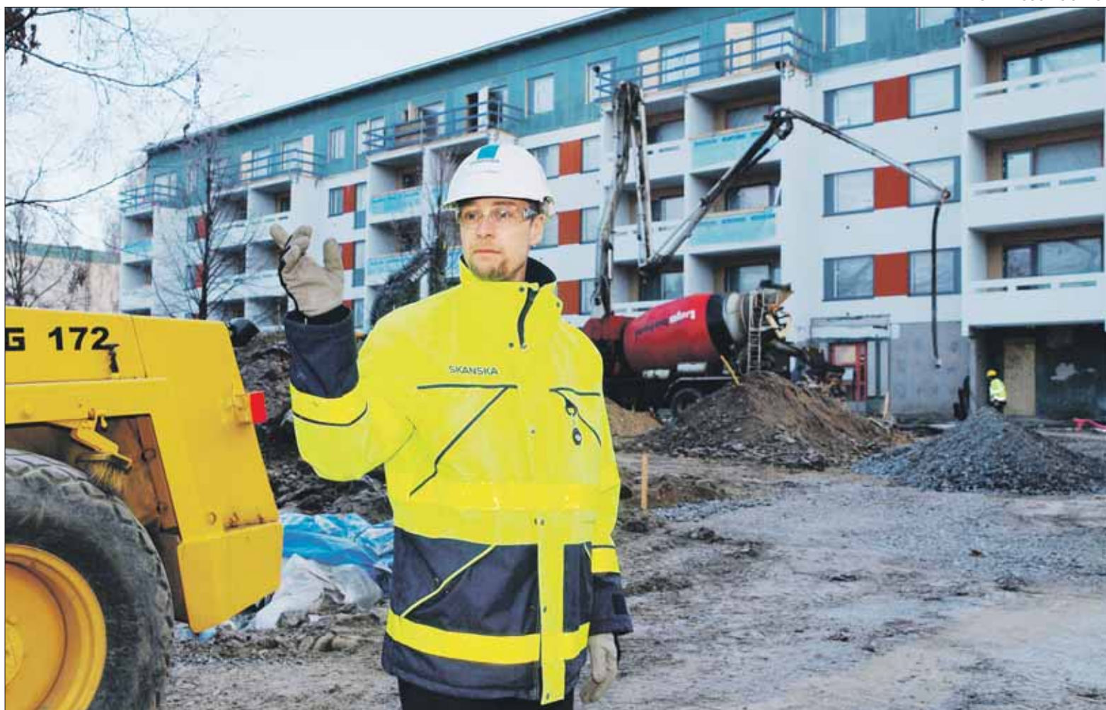
Työmaapäällikkö Petri Tikkamäki esittelee Annalan työmaata, jossa vanhat kerrostalot korjataan täysin uutta vastaaviksi. Tikkamäen takana olevaa kerrostaloa on korotettu yhdellä kerroksella. Työmiehet keuhuskelevat rakentaneensa ”sinisen rivitalon kerrostalon katolle”.
