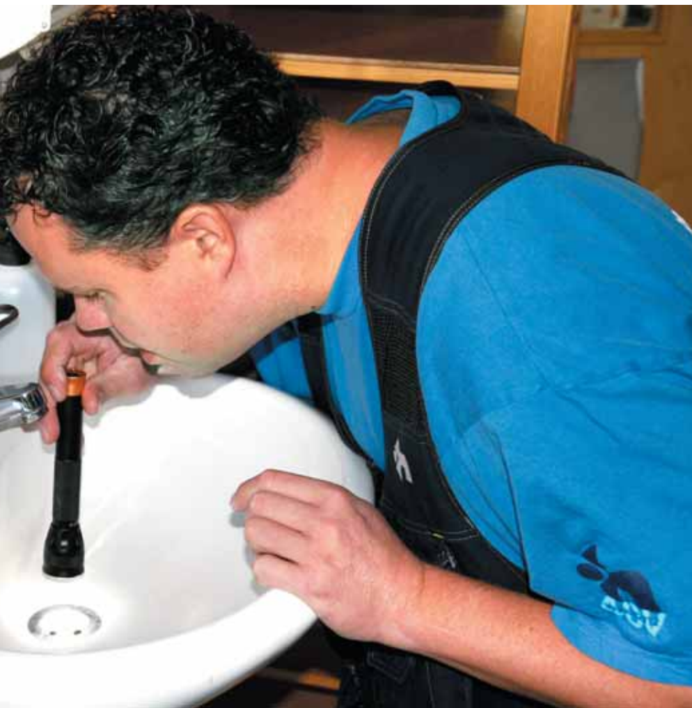
n käsienspesuallas ei vedä vettä. Miikka Siltanen poistaa tukoksen ja tarkistaa vielä lopuksi, ettei putkessa näy
