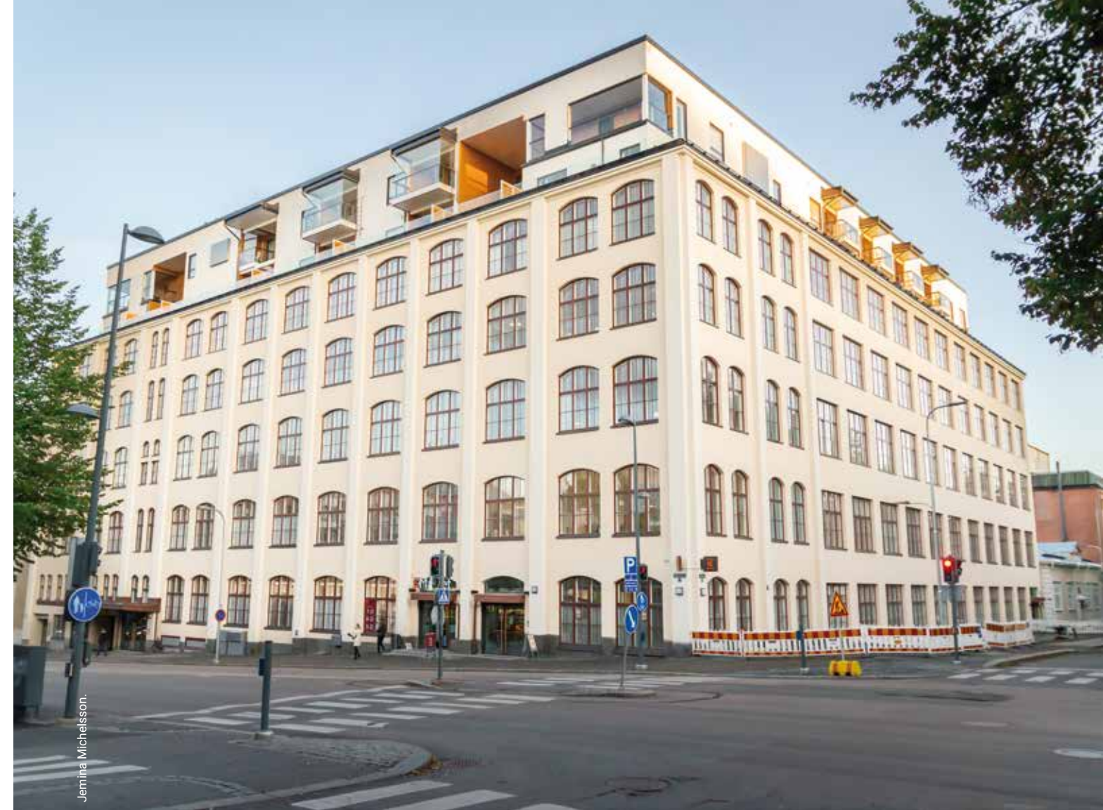
Satamakatu 17:n rakennushanke oli VTS-kotien historian suurin. Työmaalla ahkeroi 376 yritystä ja noin 2000 rakennusalan ammattilaista. Kiinteistö on kooltaan noin 90:n keskikokoisen omakotitalon kokoinen. 88
